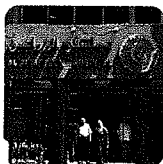
El Zerayeen Hospital 560CH (Egypt)
